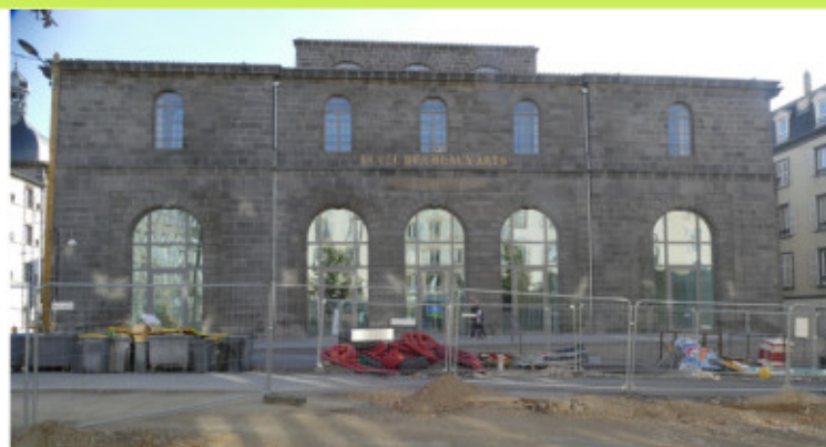
FUTUR FRAC EN TRAVAUX cliché Christian Vazelle
